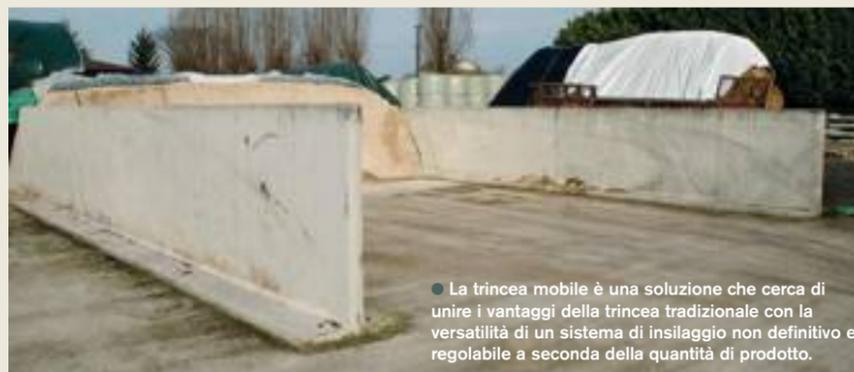
● La trincea mobile è una soluzione che cerca di unire i vantaggi della trincea tradizionale con la versatilità di un sistema di insilaggio non definitivo e regolabile a seconda della quantità di prodotto.
