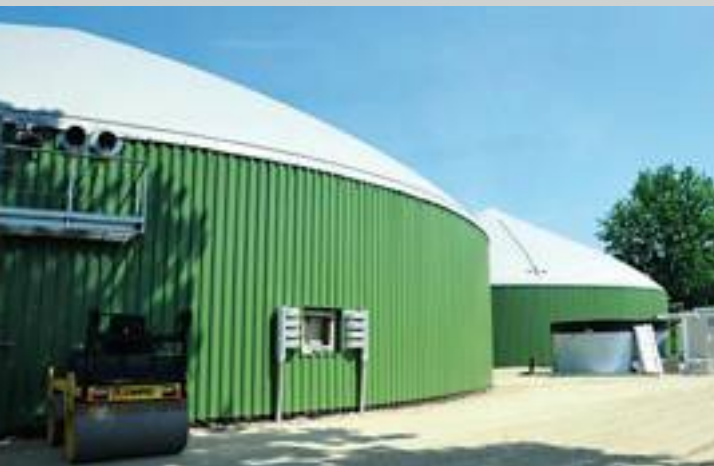
● L'impianto di un grosso allevamento di vacche da latte situato in provincia di Cremona.
