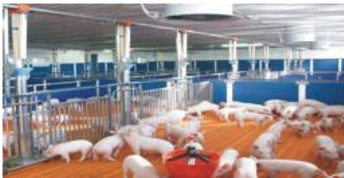
Foto 1 - Esempio di sistema di ventilazione con controsoffittatura (Fonte: Unimi).
