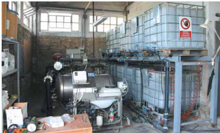
▲ Stazione di miscelazione e pompaggio dei concimi per la fertirrigazione in un'azienda specializzata del ferrarese.
